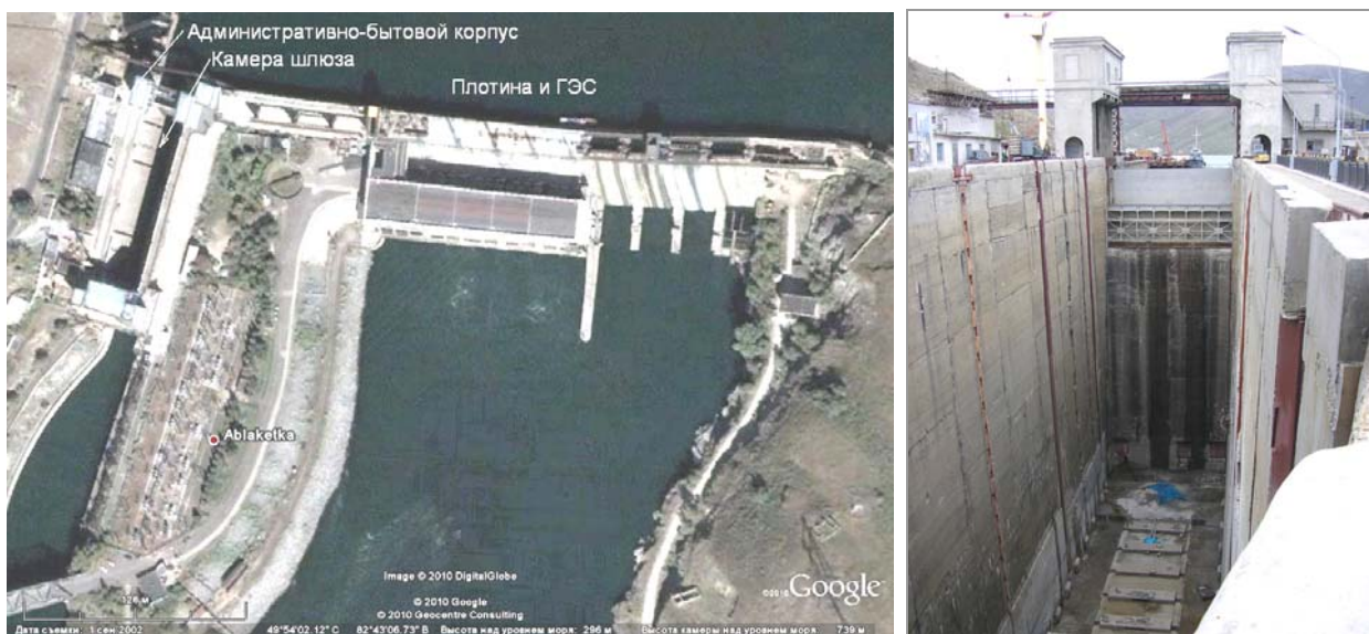
Рис. 1. Усть-Каменогорский гидроузел: a – общий вид (уровень воды в шлюзовой камере соответствует уровню нижнего бьефа); б – осушенная камера шлюза в апреле 2006 г. (вид с нижней головы шлюза)
